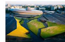
Międzynarodowe Centrum Kongresowe, JEMS Architekci i Hala Widowiskowo-Sportowa, arch. M.Gintlowt, M.Krasifski, J.Hryniewiecki, Katowice
